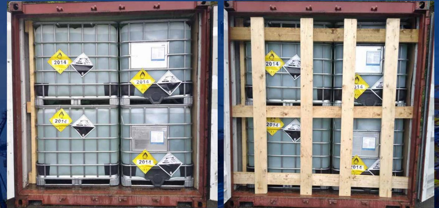
门道应该设有由3条50\*150毫米的横板（板的长度从一个波纹到另一个波纹计算（将两端锉削，以便紧密进入波纹））和4条厚度为25-50毫米、宽度为150毫米的竖板（长度由整个装载高度确定）组成的挡板。板子用直径为3-4毫米、长度为70-100毫米的钉子连接，每个关节拥有两根钉子。
